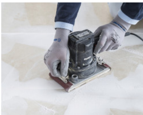
Ponçage localisé de la surface ragrée avec Planiprep 4 LVT
