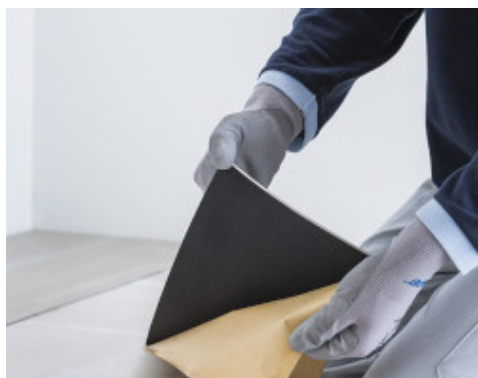
pose de LVT à envers adhésif sur ancien carrelage ragréé avec Planiprep 4 LVT
