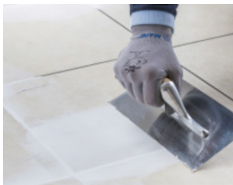
Ragrée et combler les joints sur un carrelage existant à l'aide de Planiprep 4 LVT
