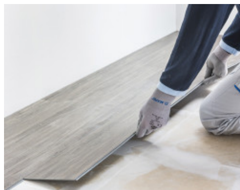
Pose de LVT Clipsable sur ancien carrelage ragréé avec Planiprep 4 LVT
