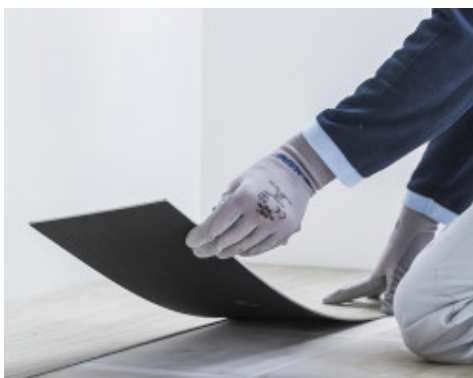
pose de LVT sur ancien carrelage ragréé avec Planiprep 4 LVT
