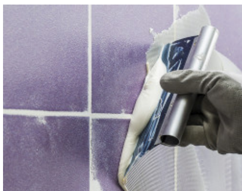
Application de Ultrabond Eco MS 4LVT Wall&Floor avec une spatule dentée sur un support non absorbant
