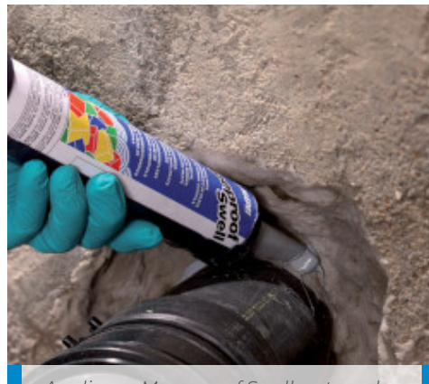
Appliquer Mapeproof Swell autour du tube
