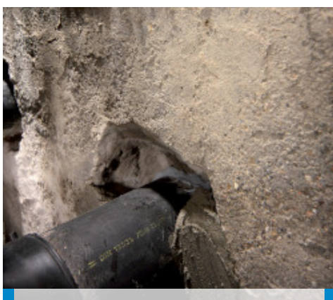
Confiner la boue de Mapeproof avec un produit de la gamme Mapegrout
