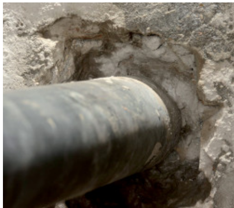
Démolir la structure autour du tube
