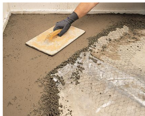
Recouvrement des tuyaux ou canalisations avec treillis métallique de renfort
