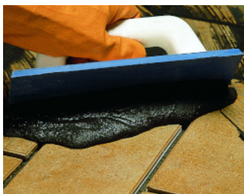
Jointoiement de grès cérame au sol à l'extérieur avec Keracolor GG mélangé avec Fugolastic
