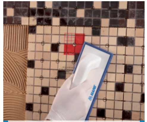
Bien presser la mosaïque et l'ajuster dans la bonne position
