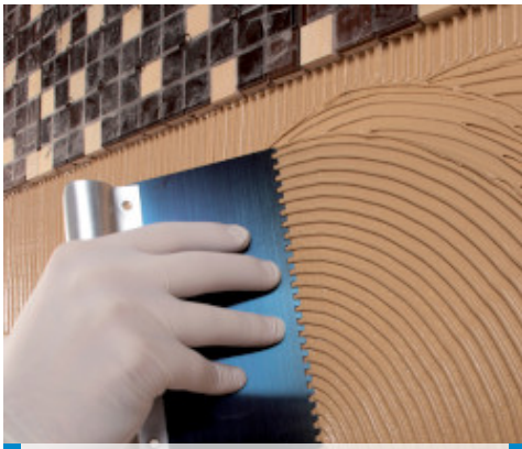
Étalement de la colle avec une spatule spéciale colle parquet
