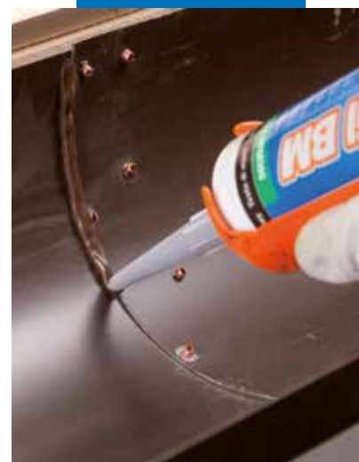
Traitement de la ligne de jonction
