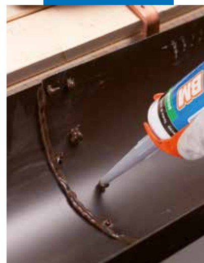
Traitement des têtes des rivets
