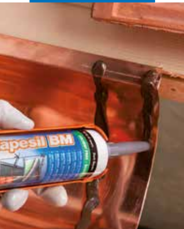
Extrusion de Mapesil BM sur la tôle du dessous avant superposition
