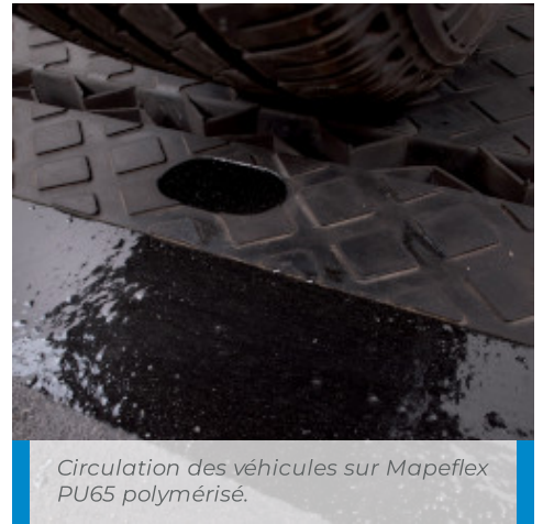
Remplissage de l'espace entre le profilé caoutchouté et le tapis d'enrobé avec Mapeflex PU65 chargé .
