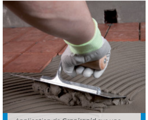
Application de Granirapid sur une terrasse imperméabilisée avec Mapelastic Zero
