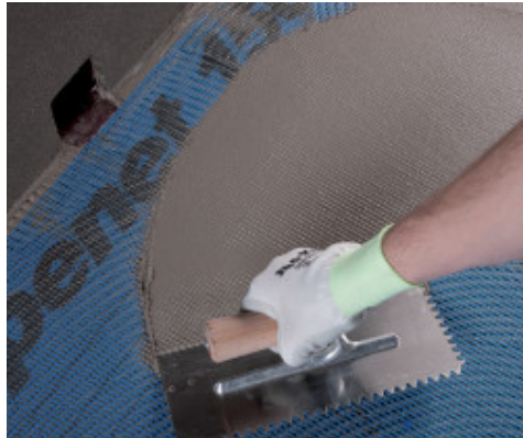
Application de Mapelastic Zero sur Mapenet 150
