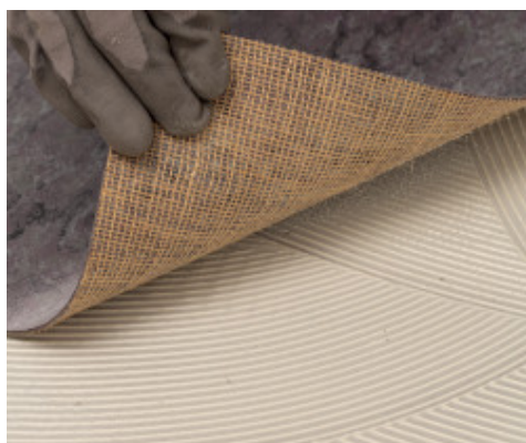
Pose d'un linoléum avec Ultrabond Eco V4 Evolution
