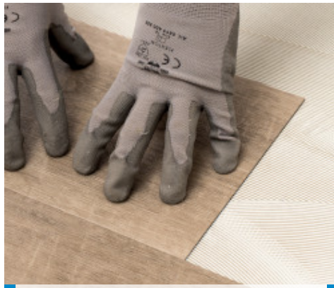
Pose d'un revêtement LVT avec Ultrabond Eco V4 Evolution
