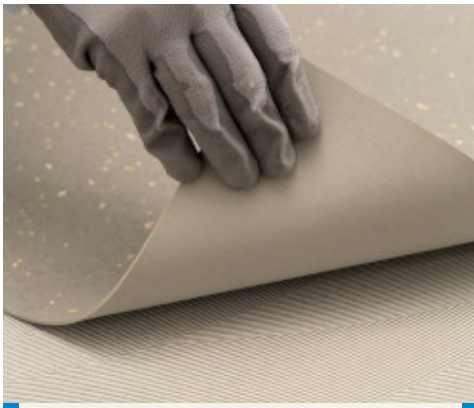
Pose d'un revêtement en caoutchouc avec Ultrabond Eco V4 Evolution
