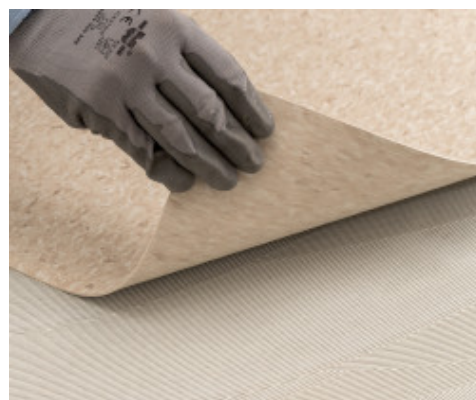
Pose d'un revêtement de sol en PVC avec Ultrabond Eco V4 Evolution
