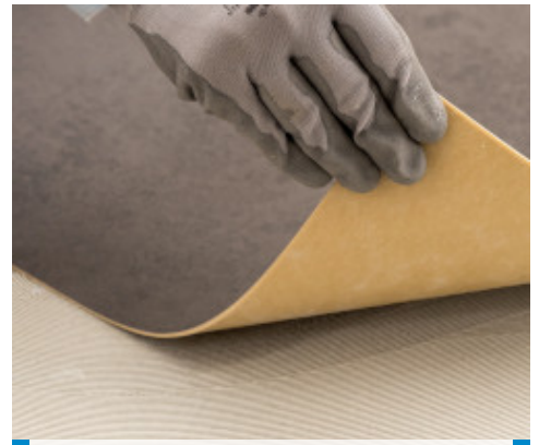
Pose d'un revêtement polyuréthane avec Ultrabond Eco V4 Evolution
