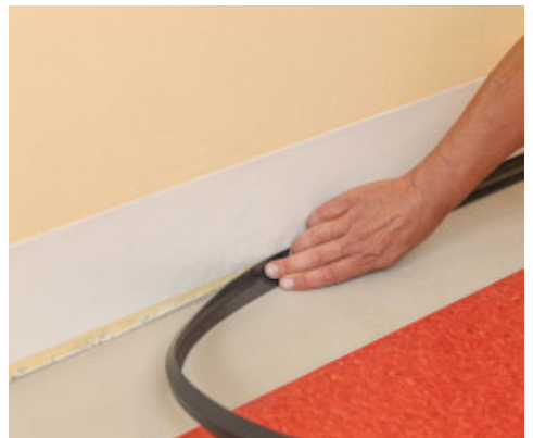
3. Pose d'un angle pré-formé
