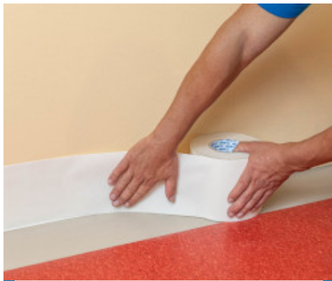
1. Application du Mapecontact Plus au mur
