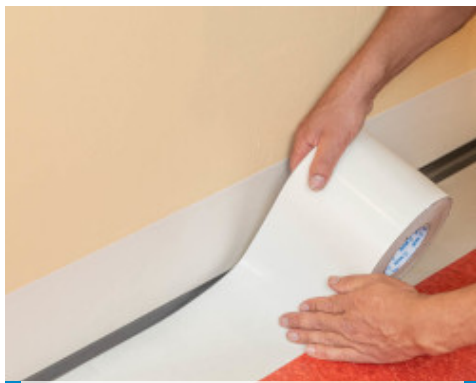
4. Mise en place d'une nouvelle bande de Mapecontact Plus au sol, puis maroufler
