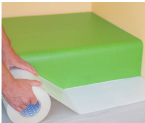
1. Afficher Mapecontact Plus sur le plat de marche et la contremarche
