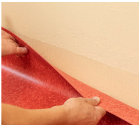
7. Pose du revêtement en mur
