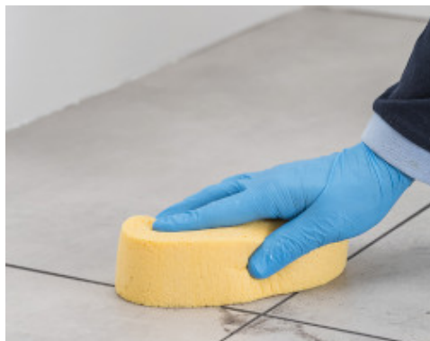
Élimination des traces de Flexcolor 4 LVT à la surface des revêtements à l'aide d'une éponge
