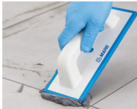
Jointoiment avec Flexcolor 4 LVT
