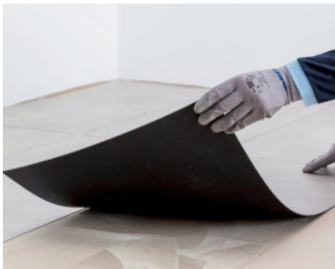
Collage de revêtements LVT avec Ultrabond Eco 4 LVT
