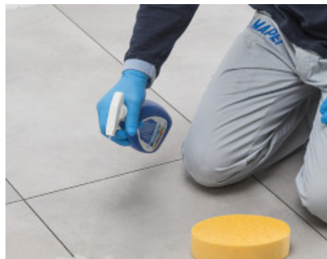
Nettoyage final avec Kerapoxy Cleaner
