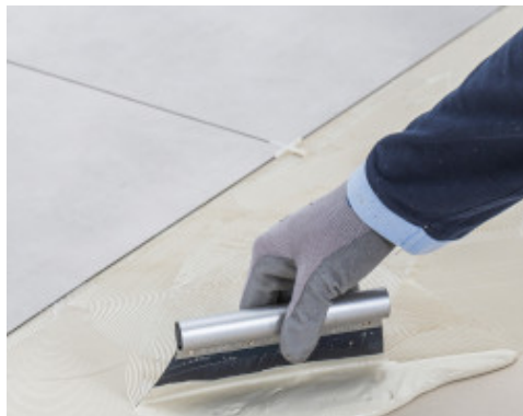
Application d'Ultrabond Eco 4 LVT et collage des revêtements LVT avec des joints larges et des croisillons
