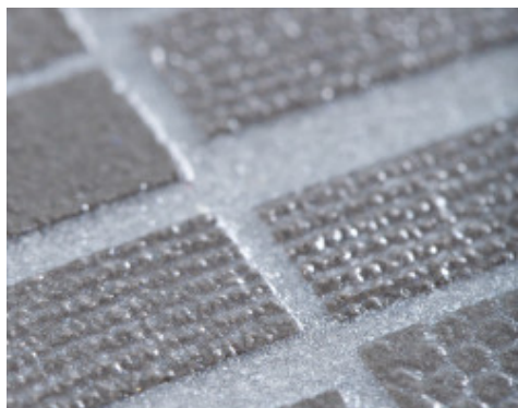
Finition avec Kerapoxy Easy Design 700 + Mapecolor Metallic Shining
