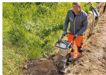
Utilisation pour la pose de câbles Spécialement conçue pour la pose de câbles et de conduites
