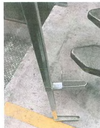
Figure 2 - Pince dalle à planches platine fixe
